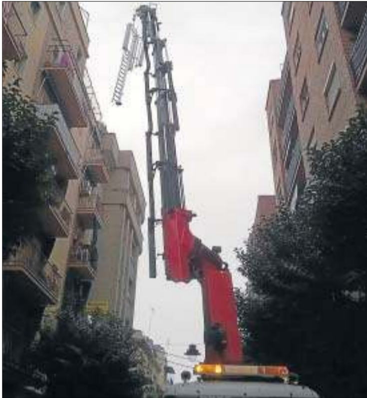
Una grua instal·lant l'antena ahir al matí.
